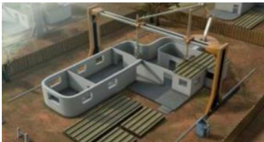
Figura 5: Esquema de construção com Contour Crafting
